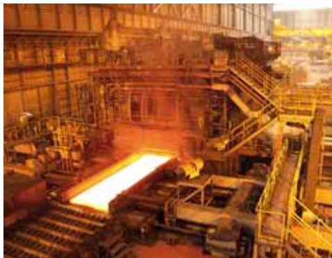
Von Siemens ausgerüstetes Grobblechwalzwerk der Dongkuk Steel Mill Co. Ltd. in Dangjin, Korea
